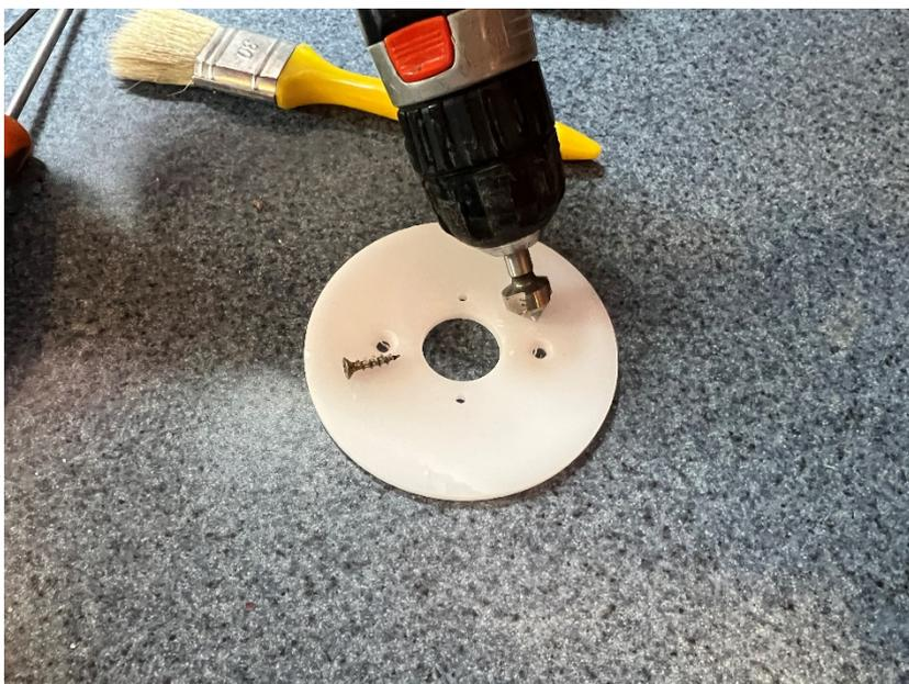
Con una punta svasatrice ho realizzato nei fori della basetta corrispondenti ai vecchi faretti, la svasatura necessaria per far entrare la testa delle viti e farle rimanere a filo una volta fissata la basetta al celetto.
